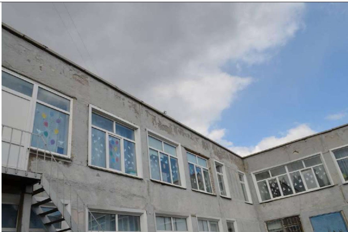
Фото №8. Общий вид фасадов здания.
