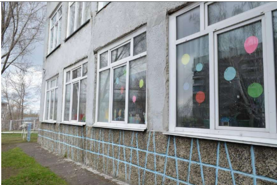
Фото №11. Общий вид фасадов здания.
