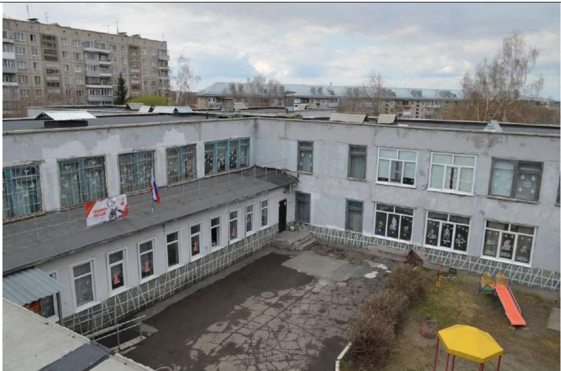
Фото №1. Общий вид фасадов здания.
