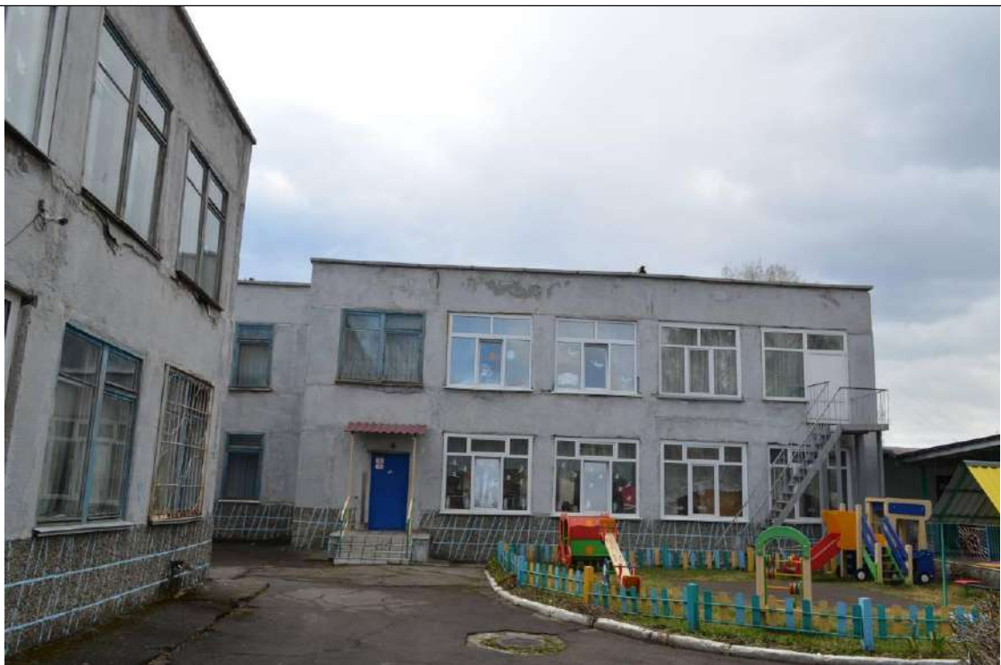
Фото №15. Общий вид кровли здания.
