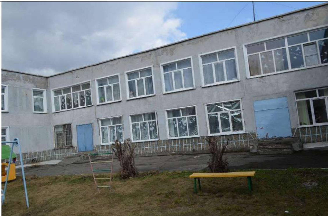
Фото №7. Общий вид фасадов здания.
