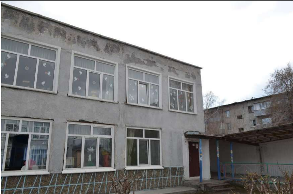
Фото №3. Общий вид фасадов здания.
