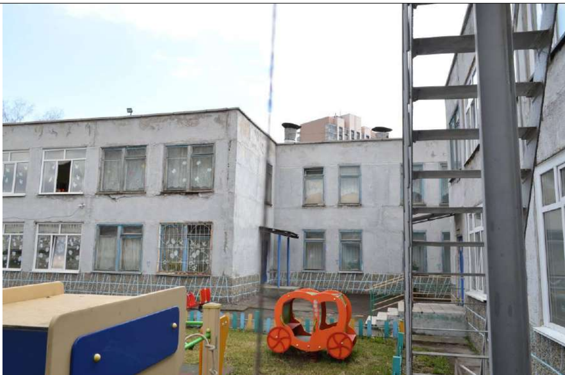
Фото №13. Общий вид кровли здания.
