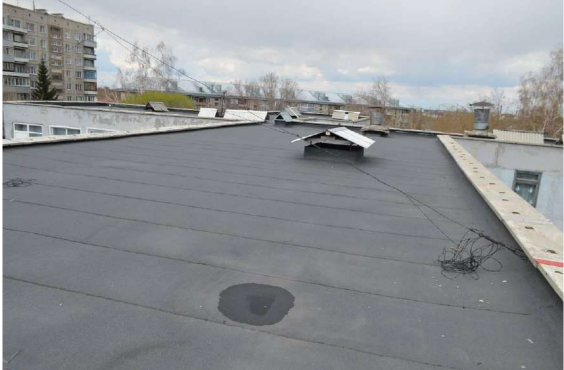
Фото №18. Общий вид кровли.
