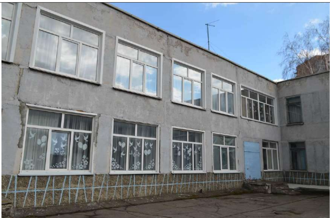
Фото №2. Общий вид фасадов здания.
