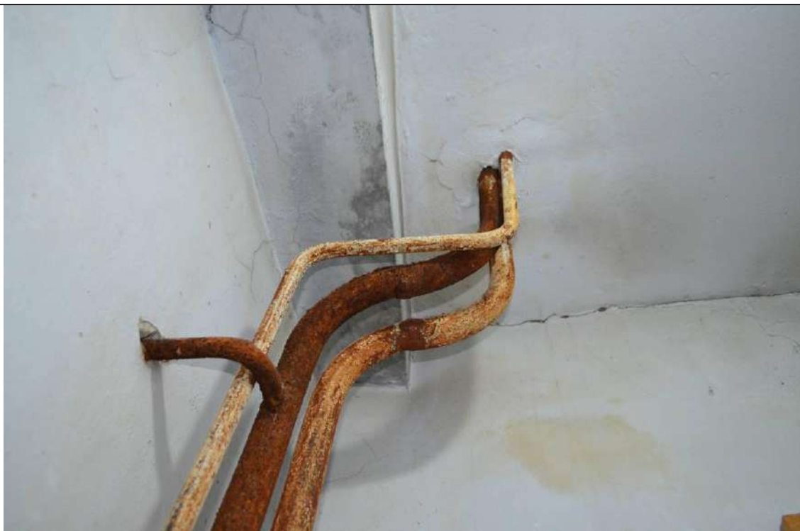
Фото №29. Общее состояние инженерных систем.
