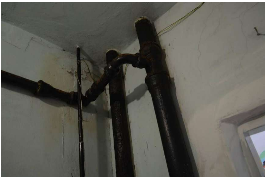
Фото №28. Общее состояние инженерных систем.
