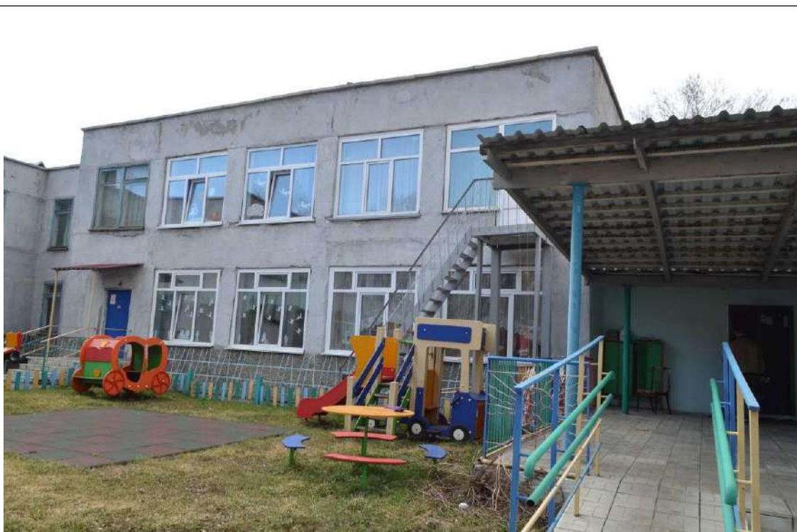
Фото №12. Общий вид фасадов здания.
